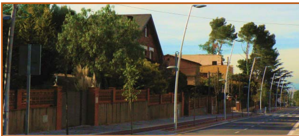
MOSEN CINTO: LES OBRES JA ESTAN ACABADES
